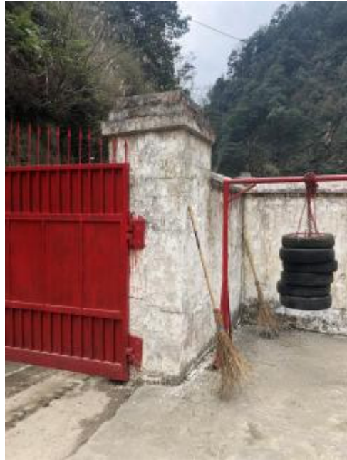
拆除新建门柱
