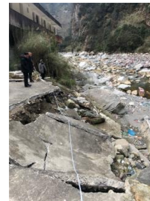
进场站内地坪恢复
