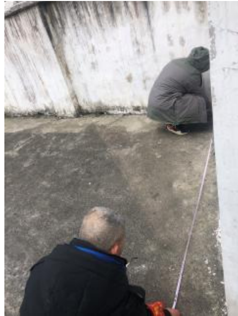
新建围墙及刷漆
