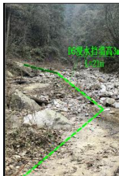
沿线挡墙 D5 (白沙坪)
