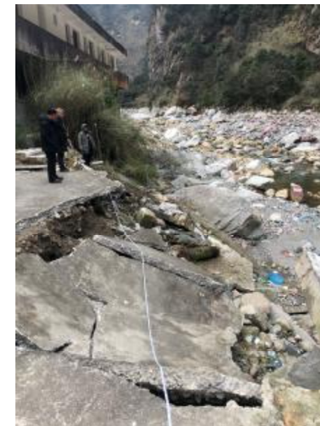
进场站内修筑挡墙
